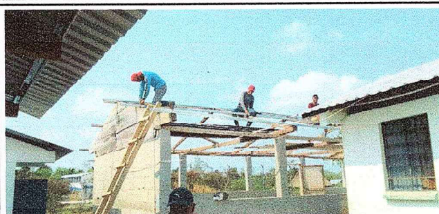
Foto 2: Aquí evidencia el proceso cambio de vigas.
