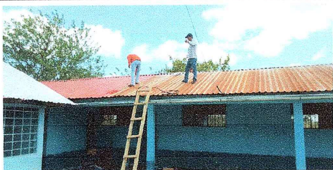
Foto 3: La fotografía evidencia sobre el inicio de cambio del entechado de las aulas.
