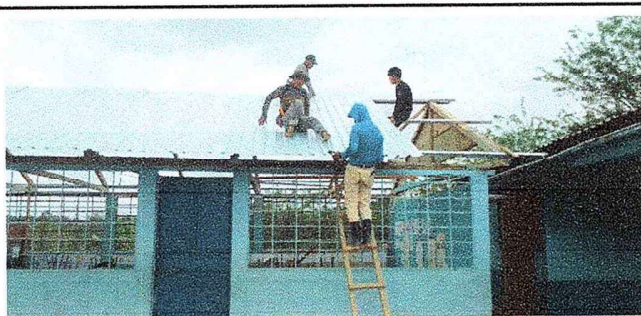
Foto 5: En esta fotografía tiene un avance del 80% del trabajo ejecutado.
