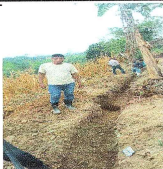
Foto 1: Esta fotografía evidencia sobre el inicio del muro de contención de block del Centro Educativo.
