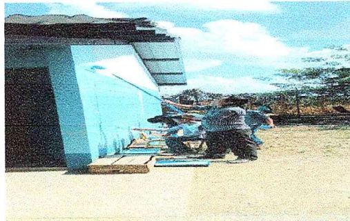
Foto 4: Es el proceso sobre aplicación de pintura.
